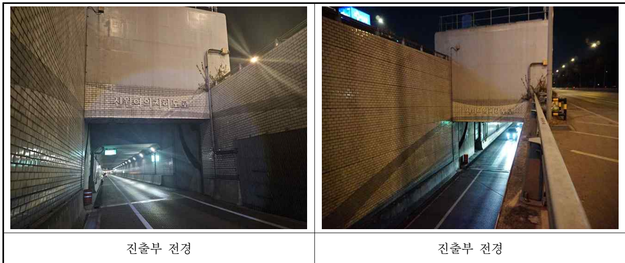
【사진 3.3.35】갯문 전경
