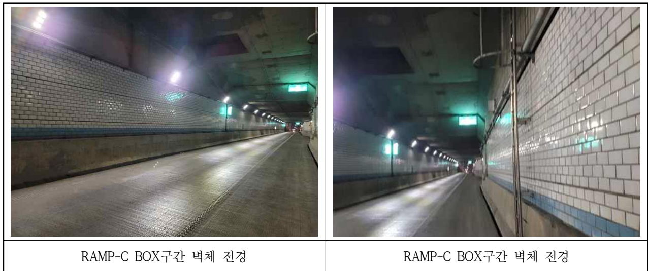
【사진 3.3.21】 BOX구간 벽체 전경
