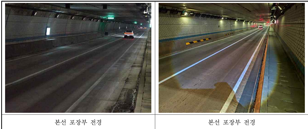
【사진 3.3.11】 포장부 전경
