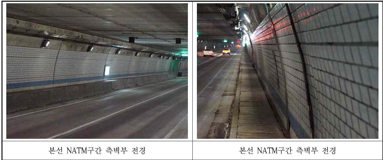
【사진 3.3.7】 NATM구간 측벽부 전경
