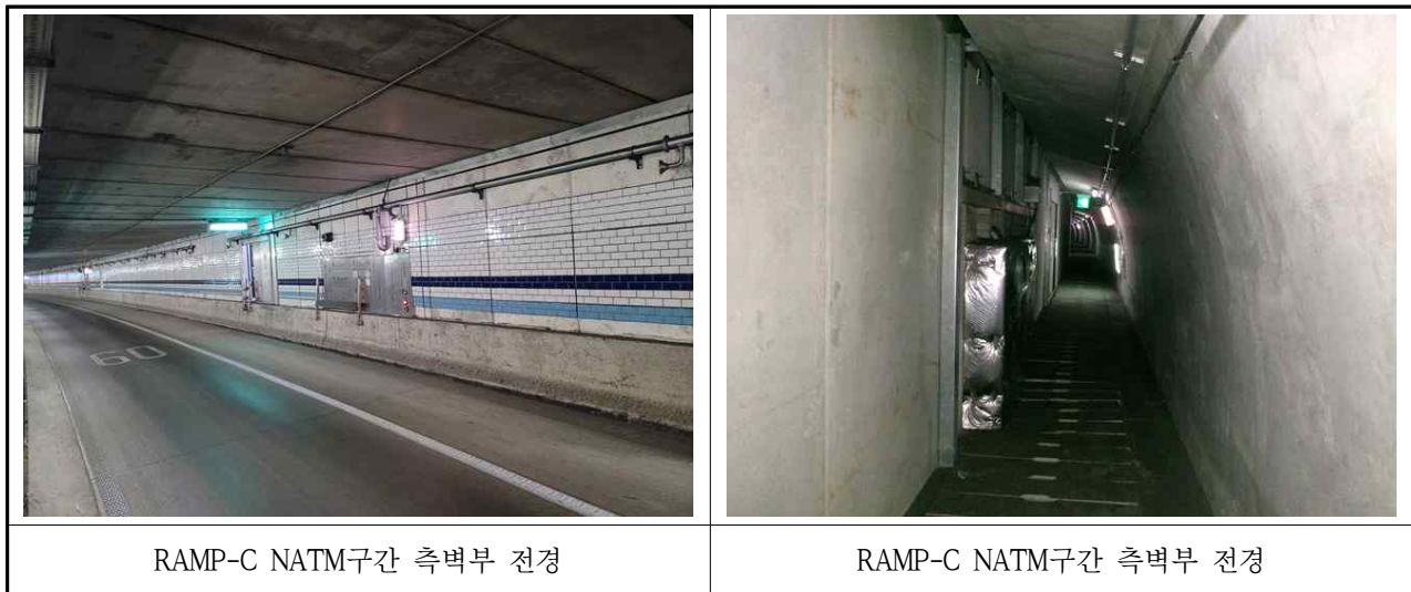
【사진 3.3.25】 NATM구간 측벽부 전경
