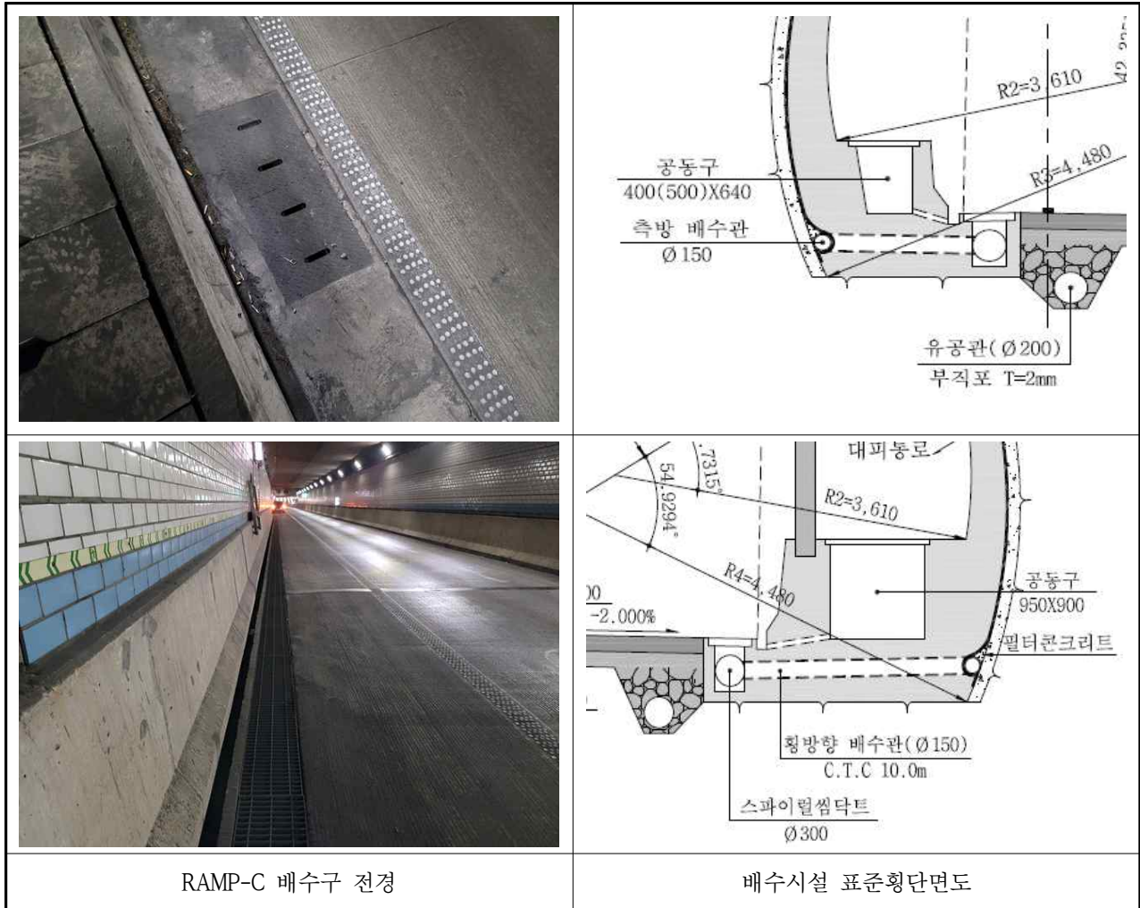
【사진 3.3.33】 배수시설 전경
